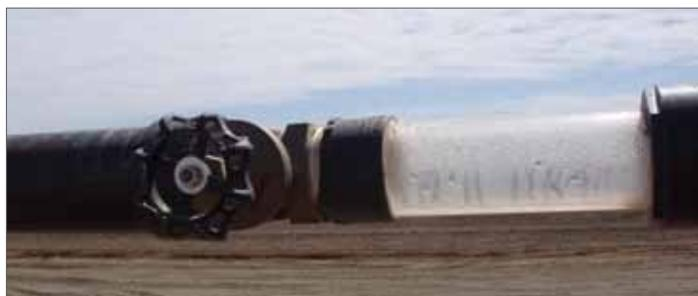
filtro cuando se retro lave el filtro. Para este propósito se instala una mirilla transparente como la que se muestra en la fotografía del lado izquierdo. Si los filtros son automáticos, es necesario revisar también que funcione bien la válvula, la bobina y el controlador. Finalmente, los filtros y las presas de sedimentación deben ser clorados de manera periódica para evitar el desarrollo de microorganismos.
